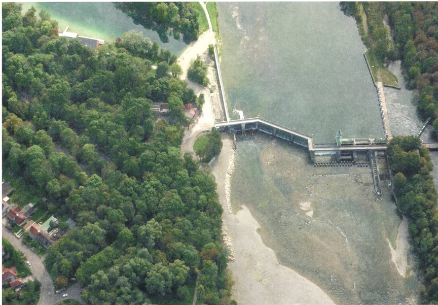
Bild 6 Wehranlage Hochablass am Lech in Augsburg, im linken Bereich die überflutete Anlage. Inbetriebnahme 2013, 2 Maschinensätze, Ausbauleistung 3,1 MW. [11]
