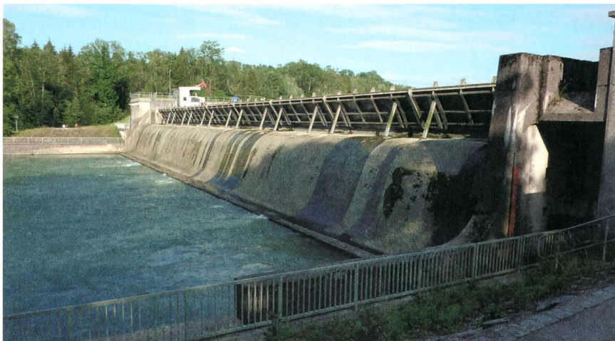
Bild 4 Unterwasserkraftwerk Lechstaustufe 15 bei Landsberg am Lech, Inbetriebnahme 1943, 6 Maschinensätze, Ausbauleistung 7,8 MW bei 8,0 m Fallhöhe. [2]
