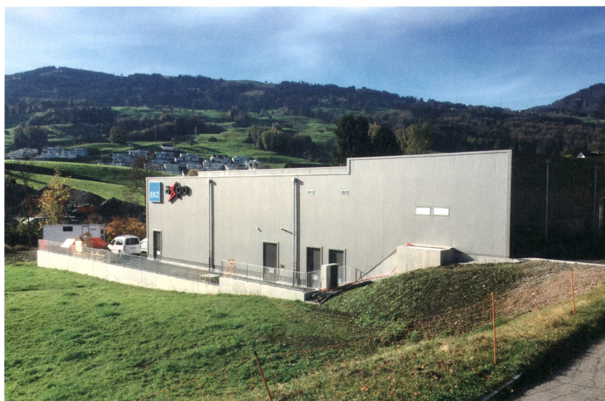
Das neue Unterwerk Etzel ist eingeweiht worden. Es wird seinen Betrieb im Juni 2018 aufnehmen.
