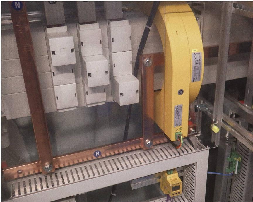
**Bild 4** Stromwandler mit Steuergerät einer Differenzstromüberwachungseinrichtung (RCM) in einer NSHV.
