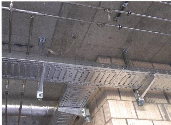
**Bild 9** Beispiel Kabeltragesystem mit grossflächiger Durchgängigkeit (4.4.4 Figur 24, empfohlene Ausführung). Nutzung als Potenzialausgleichsleiter und mit Anschluss an Bewehrung (Potentialausgleich).
