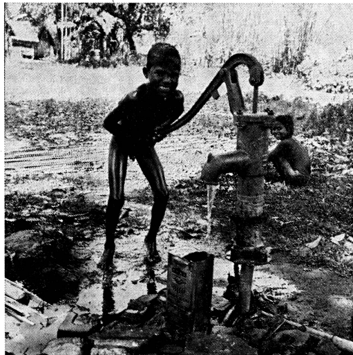
Rohrbrunnen mit einer Handpumpe vermitteln sauberes Wasser.
