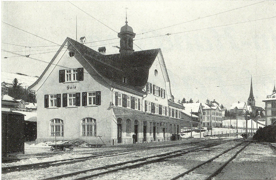
Der neue Bahnhof in Gais, erbaut nach den Plänen Salomon Schlatters.
