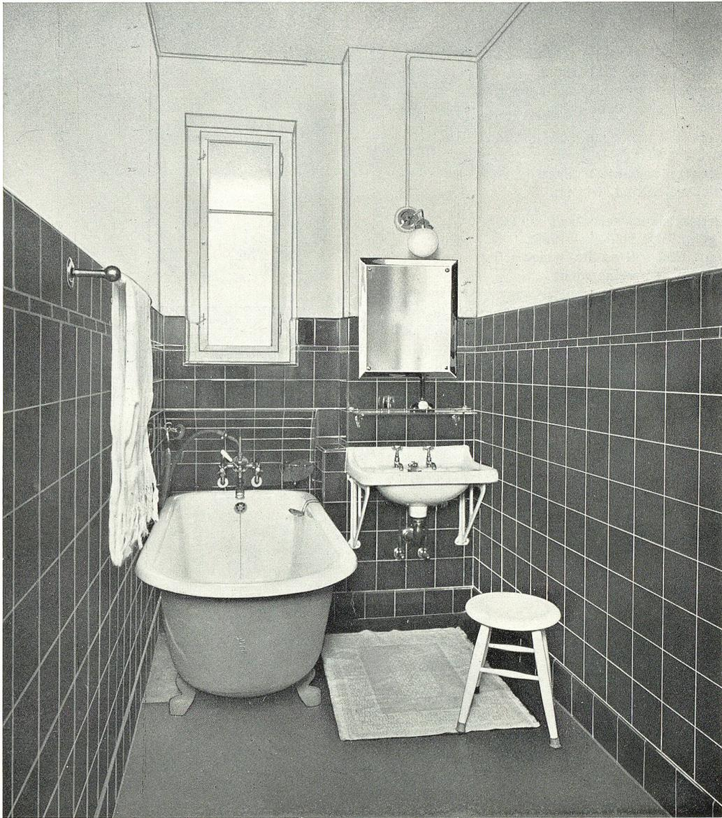
*Ausgeführte Badeeinrichtung in einer Villa am Rosenberg. Das Warmwasser wird mittelst eines in der Küche aufgestellten Gasautomaten bereitet. Beim Oeffnen eines beliebigen Warmwasserhafnes erhält man ohne weiteres sofort und zu jeder Zeit bei Tag und Nacht beliebige Mengen heisses Wasser. Der dunkelblaue Plättlibelag wirkt zu den weissen Apparaten vorteilhaft.*
