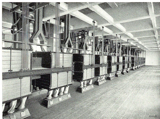
Plansichter-Saal in einer Großmühle
