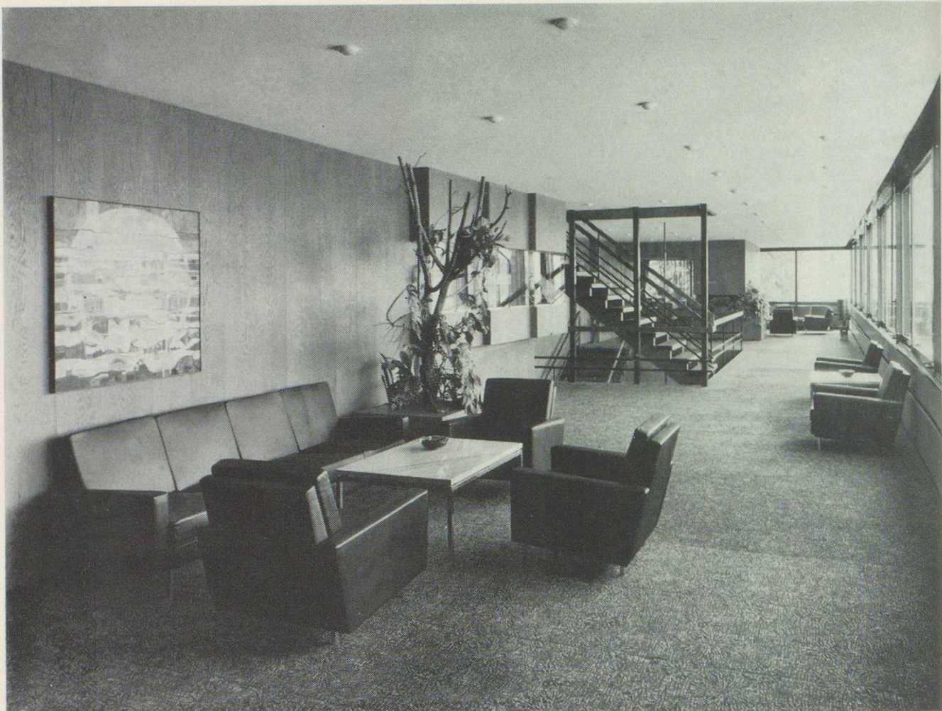
Hotel Metropol, Arbon: Ausführung des Innenausbaus
