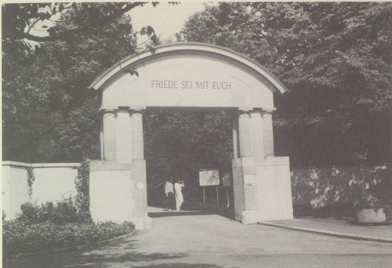
Das markante Eingangstor führt in die eingefriedete Grünfläche – ein Ort der Ruhe, der Zurückgezogenheit, der Pietät.
