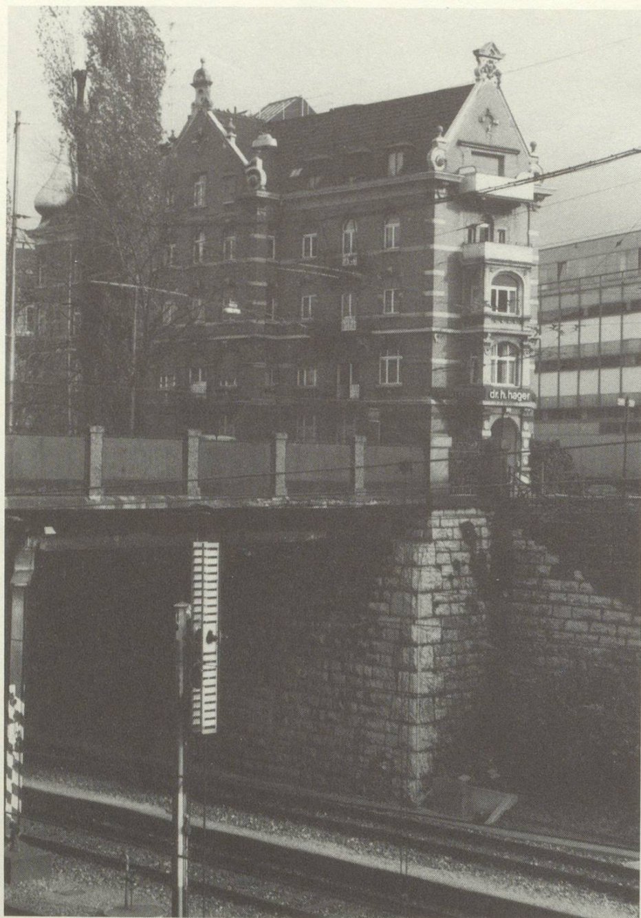
Gequaderte Stützmauern fassen den Einschnitt der Bahn und bilden in Material und Bauart eine Einheit mit den Sockelpartien der Hochbauten, was eine starke räumliche Integration der Überführung brachte. (Foto M. Ferrier)
