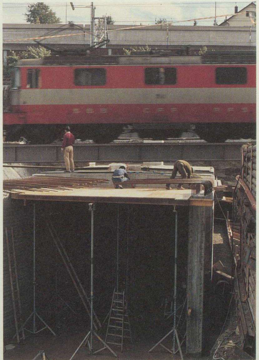
Anschließend wurde unter den Hilfsbrücken der Auslaufkasten betoniert.
