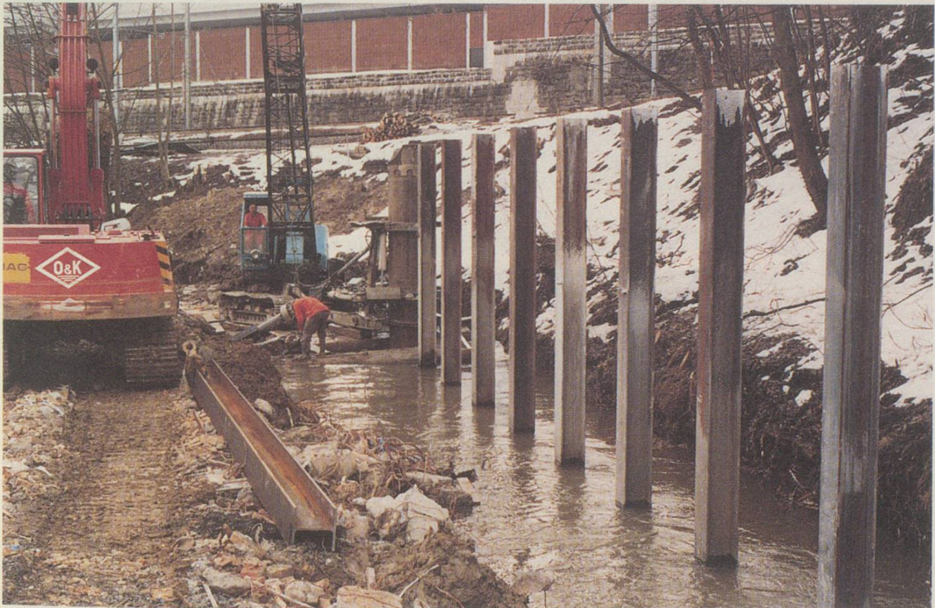
Rühlwand für den flutsicheren Bau des Steinachstollens. Die Träger wurden anschliessend ausgefacht und dahinter der Bahnhof für die Stollenbahn angelegt, in dem 42 000 m 3 Material umgeschlagen wurden.
