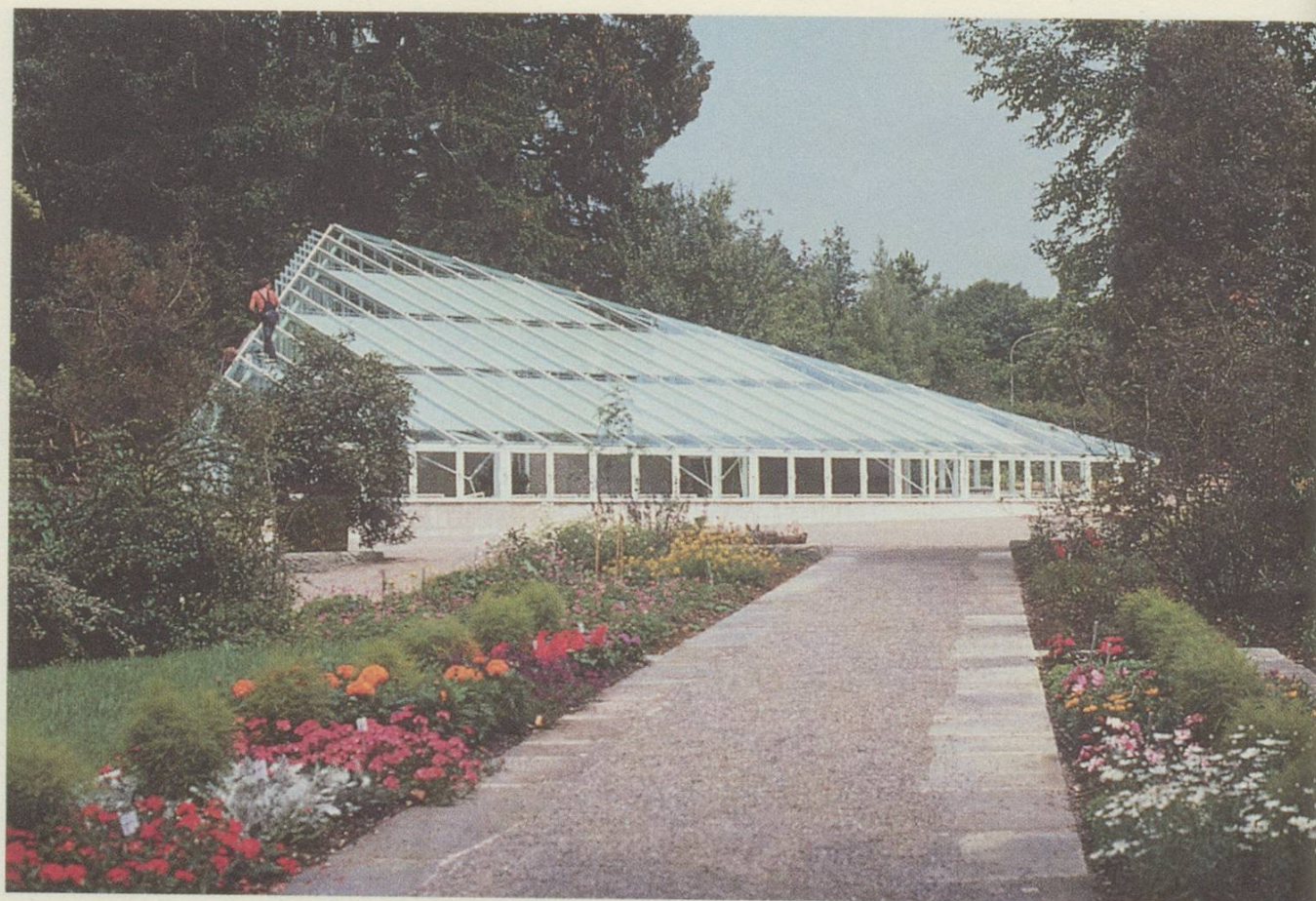
Das neue Alpinenhaus kurz vor der Fertigstellung im Jahre 1993.
