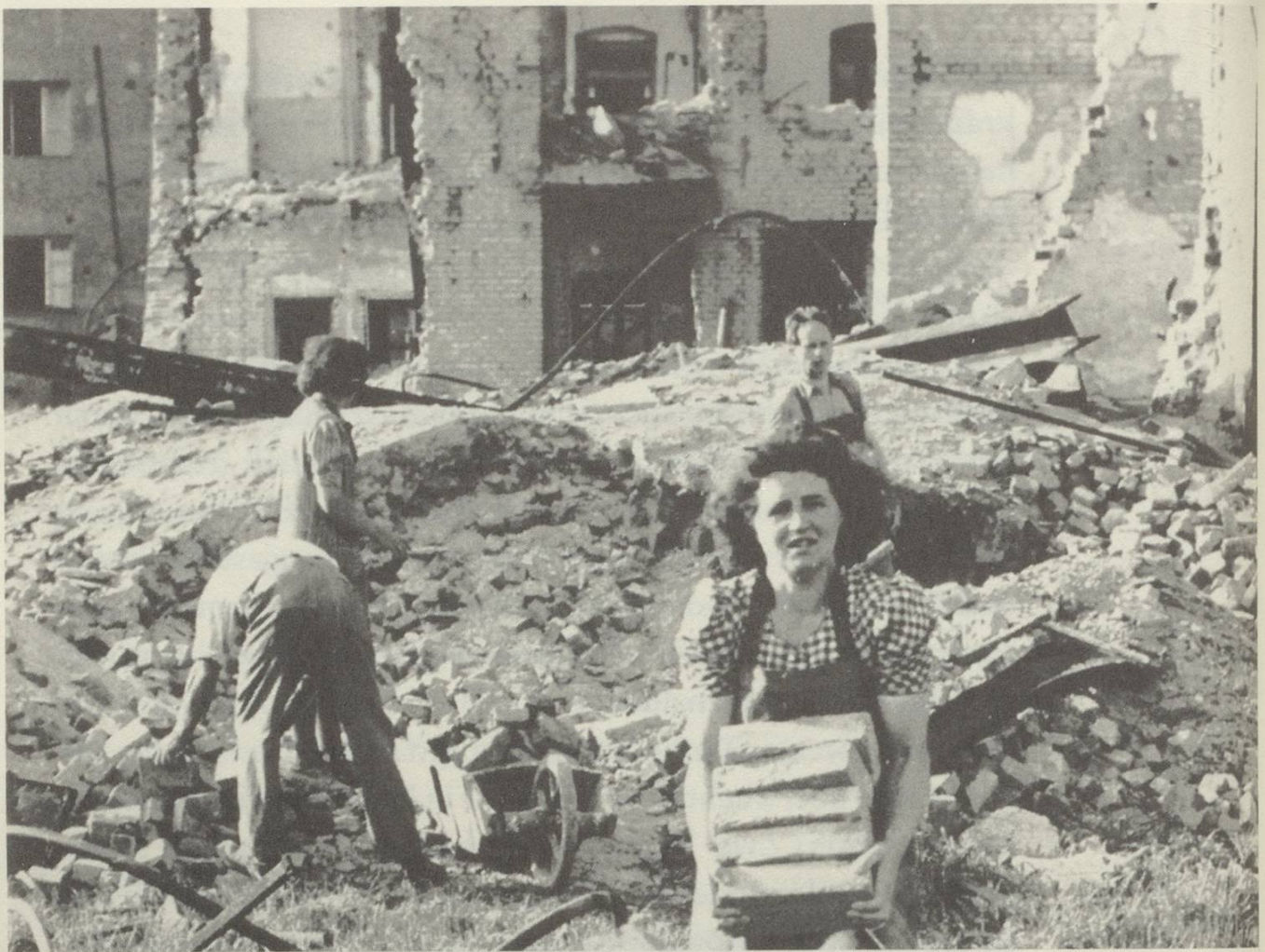
Mit Hilfe von Schutt der zerstörten Häuser werden Wohnungen notdürftig instand gesetzt.
