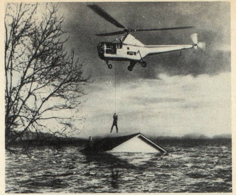
Diejenigen, die das höher gelegene Schulhaus nicht mehr erreichen konnten, hatten sich auf die Dächer geflüchtet, von wo sie später von Hubschraubern einzeln gerettet wurden
