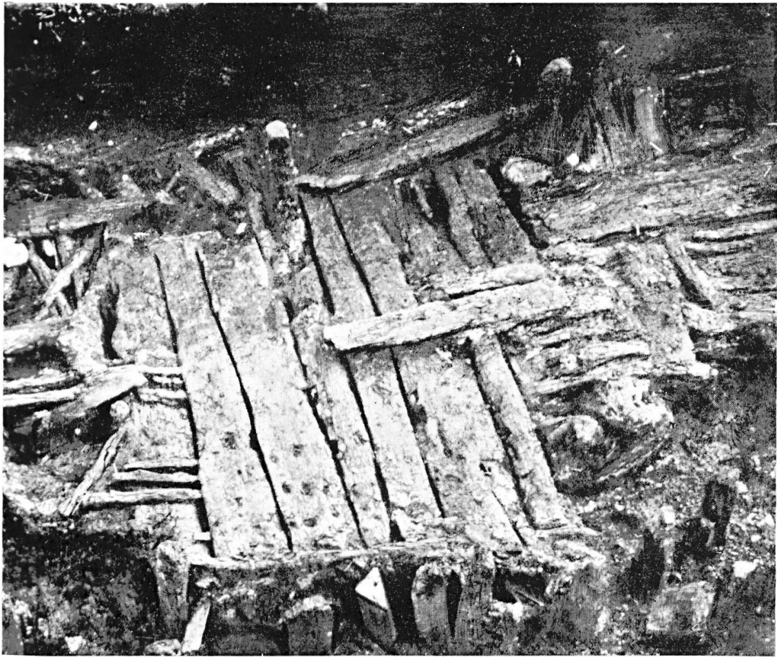
Abb. 3 Breitenloo-Pfyn, Photo einer Hüttenecke man erkennt deutlich Rahmenwerk, längsliegende Prügelhölzer und eichene Bodenbretter
