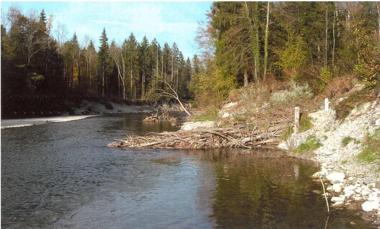
Abbildung 5: Mittlerer Teil der Auenstrecke flussabwärts, mit Holzбуhne am rechten Ufer (Streifen Nr. 15 mit tiefem Kolk auf der Oberseite und tiefer Rinne in Fließrichtung am Bühnenkopf), am linken Ufer Streifen 11–14.
