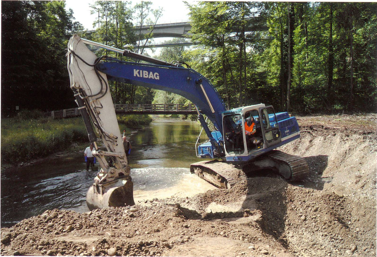
Abbildung 6: Durchstich mit Raupenbagger zur Flutung des neuen Gerinnes.
