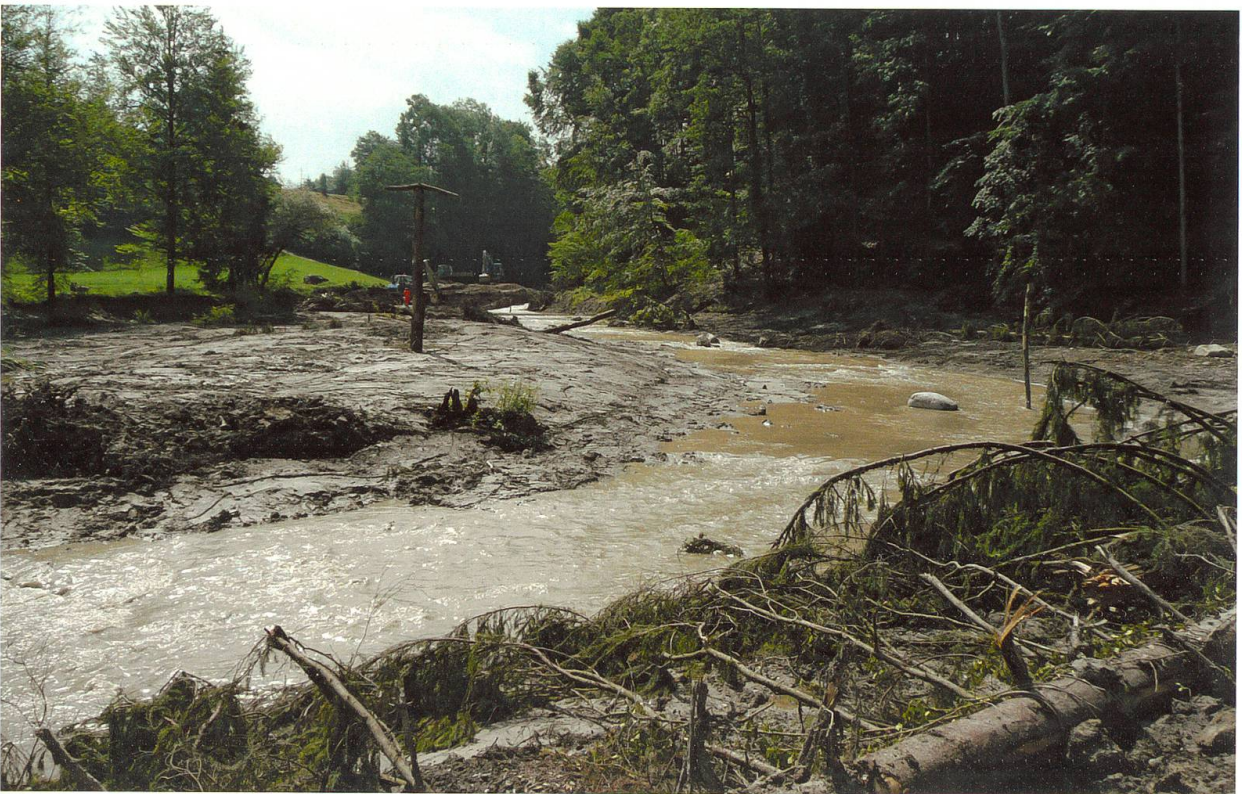
Abbildung 7: Die Flutung des neuen Auengebietes. Im Vordergrund Raubäume zum Schutz des abgelagerten Materials.
