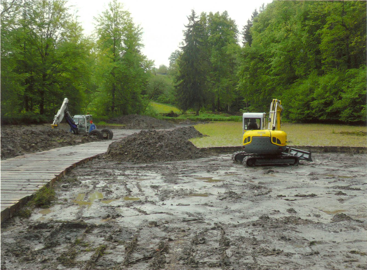
Abbildung 3: Bauarbeiten im abgetrockneten Weiher.
