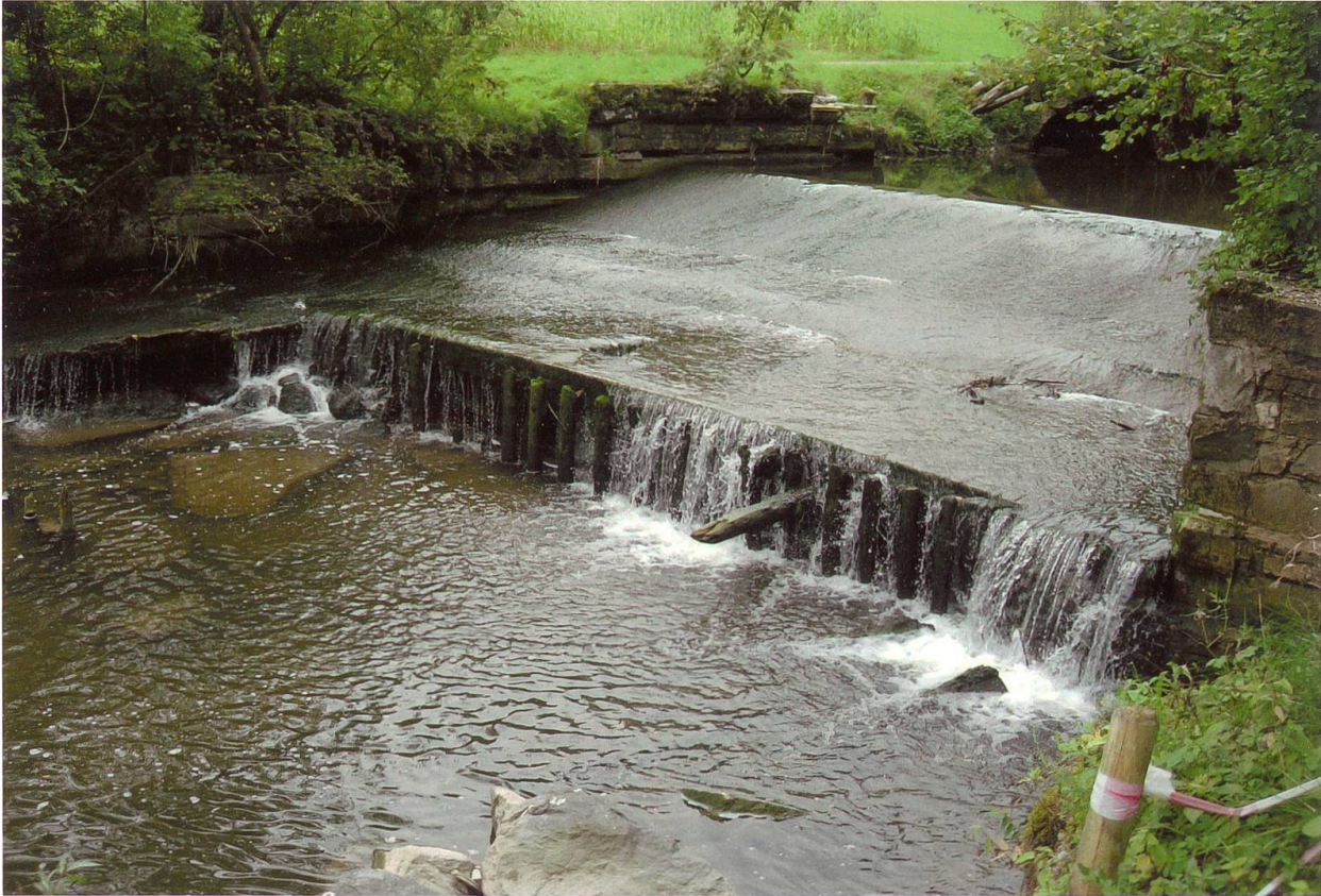
Abbildung 2: Oberes Stauwehr Isenhammer: Ein Betonwehr von 1.8 m Höhe verhindert seit etwa 150 Jahren die Wanderung von Fischen flussaufwärts.
