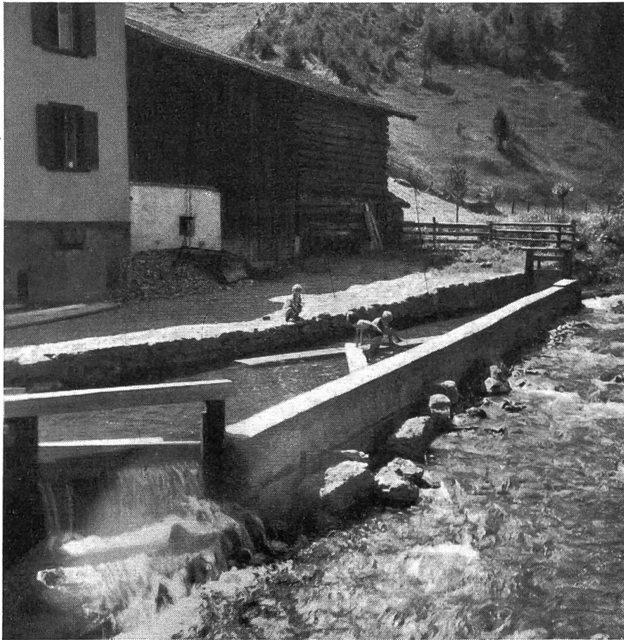
Abb. 2. Sandschwelle am Mönchalpbach in Klosters.
