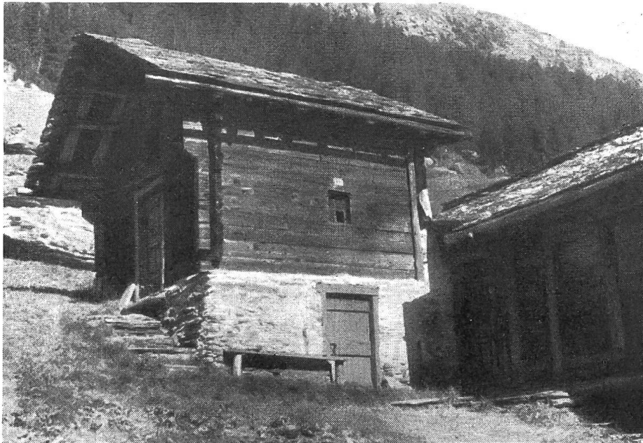
Abb. 3. Neueres Schlafhaus in Valbella. Der ursprüngliche Habitus ist gewahrt, auch das weit vorgezogene Dach fehlt nicht. Der Unterbau enthält einen Milchkeller. Der Herdraum befindet sich im quer dazu stehenden Wirtschaftsbau (Heustall mit Wohnküche).
