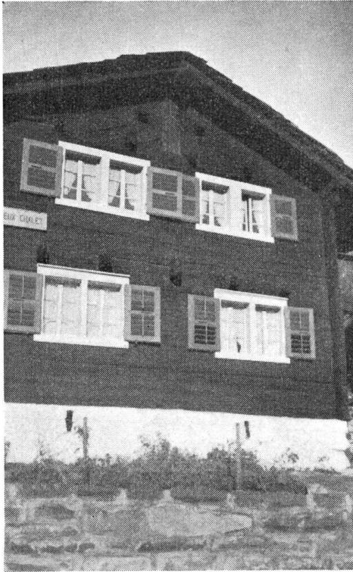
Abb. 3 – Salvan Unter dem Dach Heidenrost mit Kreuzbalken
