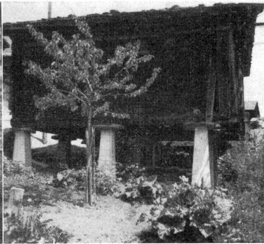
Stadel auf Mäuseplatten, darunter Betonpfähle Ferden, Lötschental
