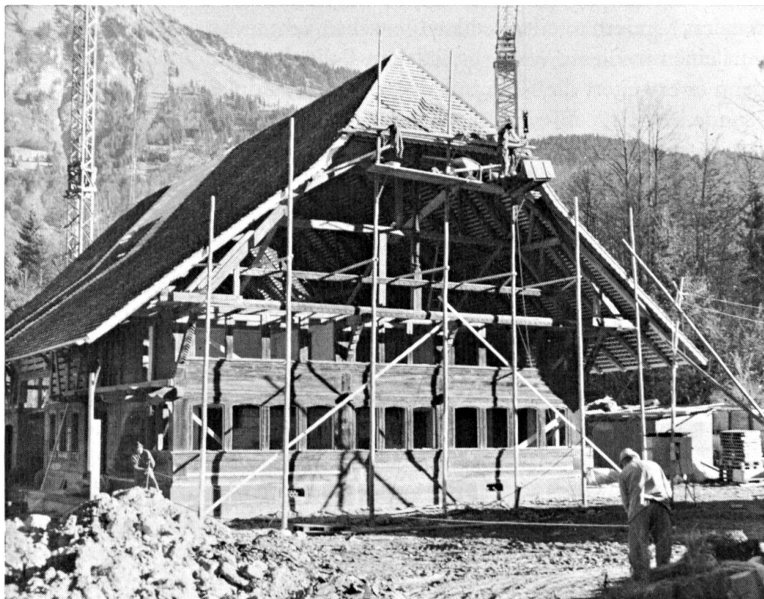
Haus von Ostermundigen im Wiederaufbau.
