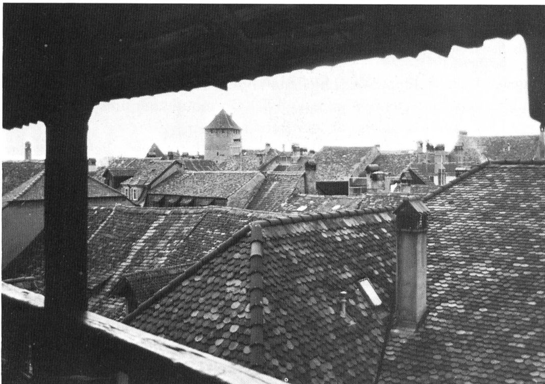
Murtens Dächerlandschaft, von der Ringmauer aus gesehen (Foto: Archiv FN)
