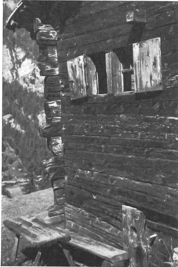
Fig. 3. Paroi extérieure, côté sud.
