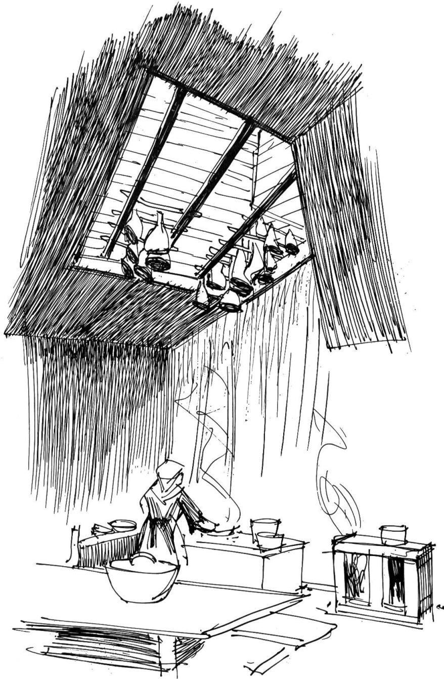
Fig. 9. Cuisine surmontée d'une cheminée en planches. Le fourneau potager n'a pas de conduit de fumée. A droite, un autre fourneau, qui sert à cuire la nourriture des cochons. Au premier plan, la table de famille. – Bundtels (Fribourg).
