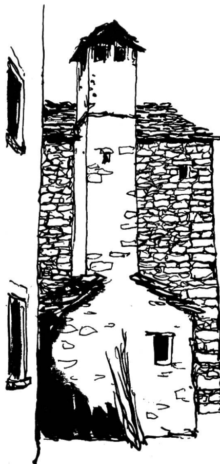
Fig. 12a. Cheminée accolée: elle surmonte la niche qui renferme le foyer.
