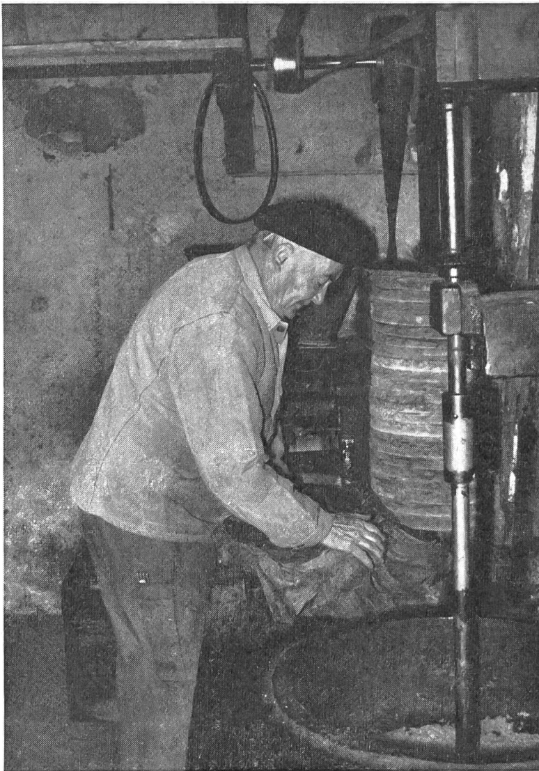
Fig. 3. L'huilier emballe la pâte dans des toiles de jute; sur le devant: la chaudière avec l'agitateur ( brasse ).
