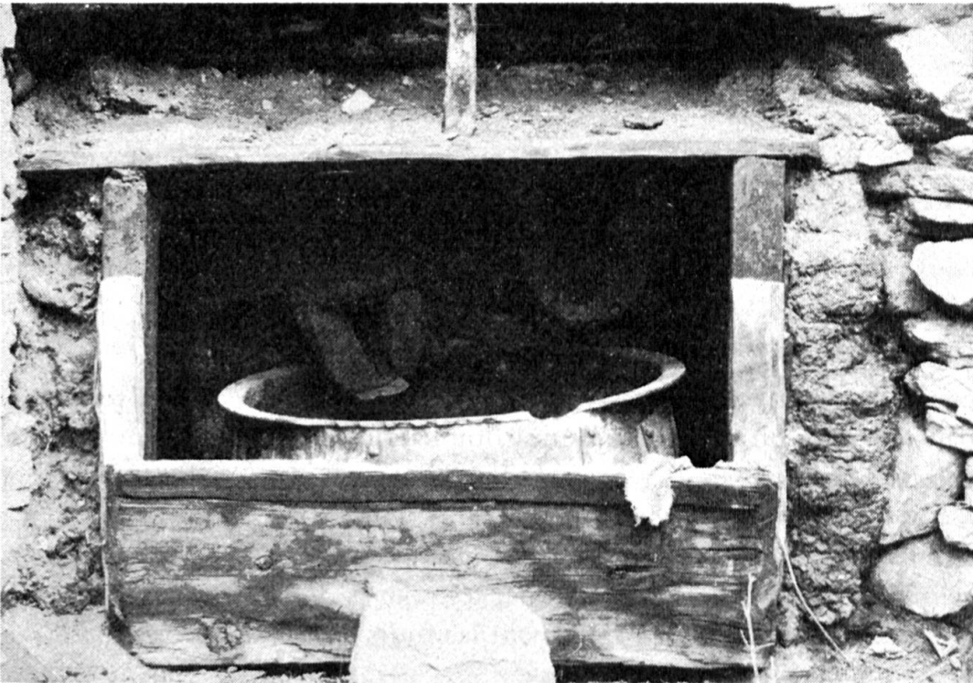
Le chaudron dans sa niche avec les deux coulisses de mélèze par où s'écoulaient les goudrons.
