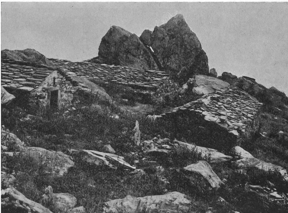
Fig. 2. Bagnes, alpage du Crêt, constructions en pierre.
