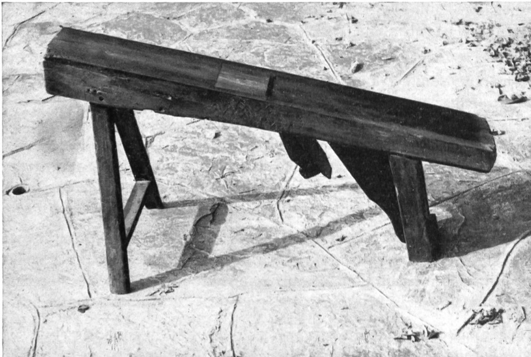
La colombe. C'est le grand rabot renversé des tonneliers et des charrons.
