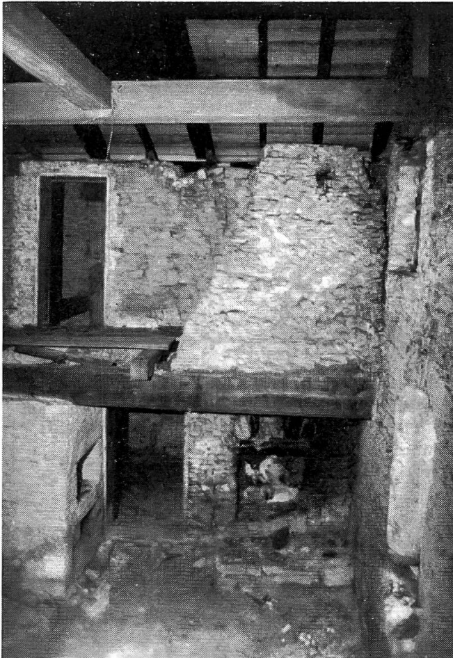
Fig. 9. Vue générale d'une cloche dont le conduit de fumée ne débouchait pas sur le toit, mais dans la grange (le plafond de la cuisine a été enlevé pour être remplacé) La Bosse.
