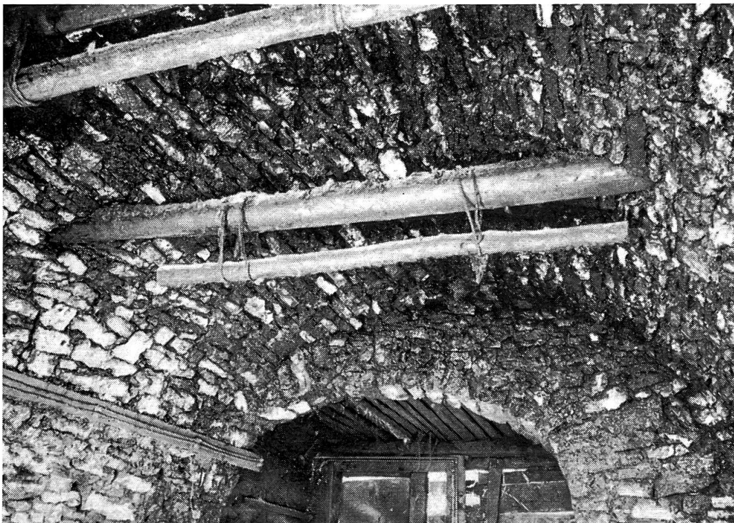
Fig. 3. Cuisine voûtée avec les rondins pour suspendre la viande à sécher, le « rabat-fumée » et, à l'arrière-plan, les « rondelats » (Bois-Rebetez).
