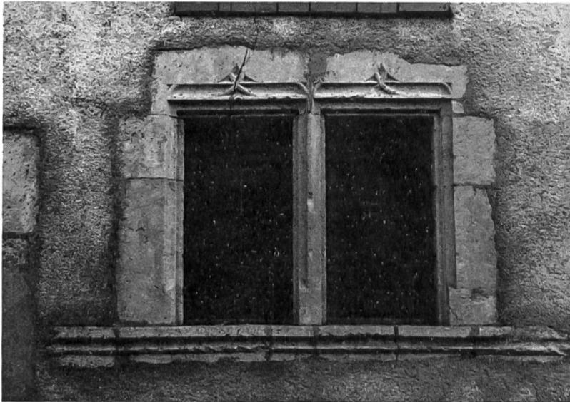
Fig. 26 Bofflens. Fenêtre à meneaux décoré de moulure et de linteaux en forme d'arc infléchi (XVI<sup>e</sup> siècle).
