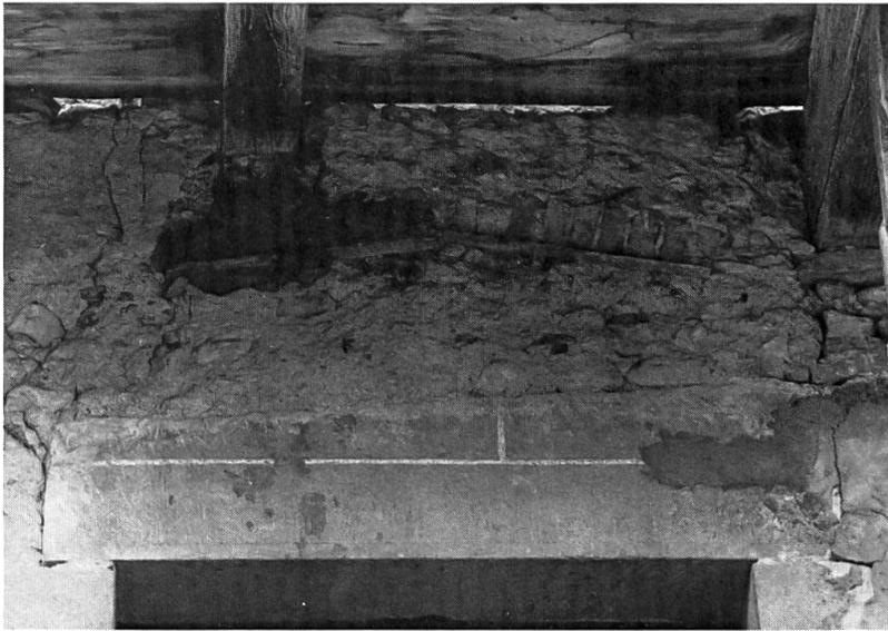
Fig. 25 Fiez. Arc de décharge du linteau d'une fenêtre composé de deux planches épaisses et de briques.
