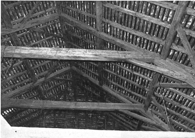
Fig. 34 Vugelles-la-Mothe. Exemple de charpente à tirants.
