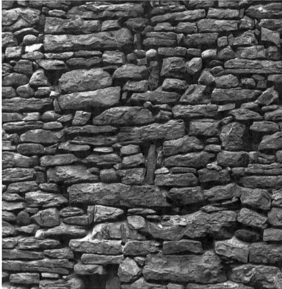
Fig. 22 Onnens. Exemple de maçonnerie de pierres constituée par des pierres plates soigneusement empilées. A l'origine, le mur devait être recouvert par un crépi.
