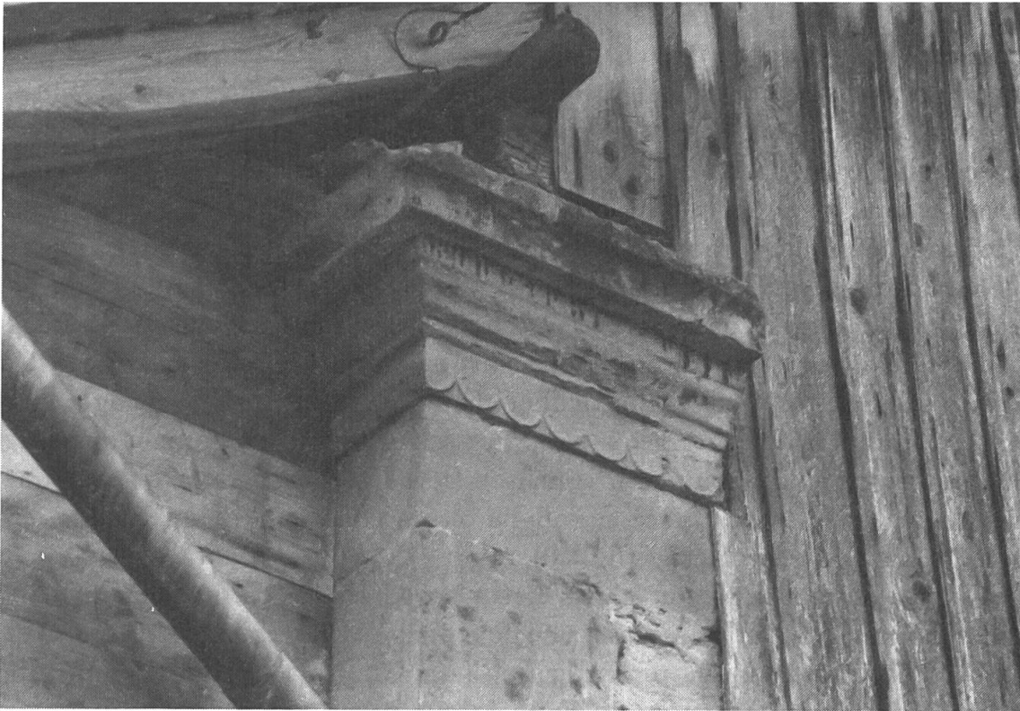
Fig. 7 Pailly (cad. 134), maison paysanne de 1792, maçon Isaac Buloz; chapiteau librement inspiré du dorique, souligné d'une frise de festons reflétant la fantaisie du tailleur de pierre.
