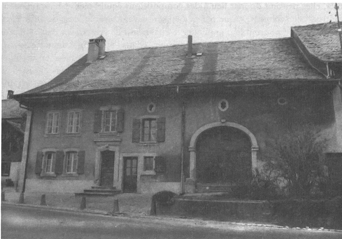
Fig. 3 Orzens (cad. 59), maison paysanne de 1791; disposition régulière des œils-de-bœuf en façade. L'un deux, d'une forme plus complexe, vient souligner l'axe de la porte de grange.
