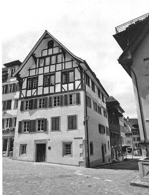
Abb. 1: Haus St.-Oswalds-Gasse 10, Zug. Aussenansicht von Nordosten nach der Renovation von 2007/08. Quelle: Amt für Denkmalpflege und Archäologie Zug, Direktion des Innern (Brigitte Moser).
