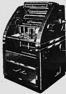
UNTER VIELEN GUTEN EINE HERVORRAGENDE — die Kleinoffsetmaschine ZETAPRINTON 30
