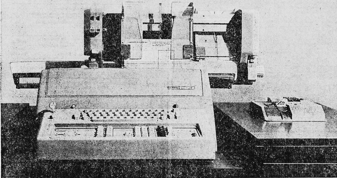
HERMES C-3, Buchungsautomaten nach Mass, können von 3 bis zu 11 Rechenwerken ausgebaut werden. Sie sind mit Volltext und, sofern erwünscht, mit Kurztext-Tastatur ausgerüstet. Aussergewöhnliche Vielseitigkeit durch Steuerschienen mit 4 und Tabulatorschiene mit 8 Pro-
