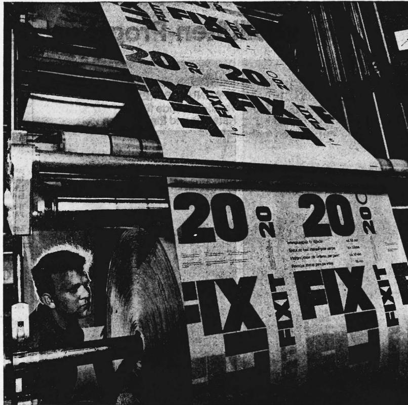
Die Pavag-Säcke sind an den wirkungsvollen Aufdrucken leicht zu erkennen. Die spezifischen Merkmale sind der saubere, oft mehrfarbige Druck und die bei Grossformatsäcken nicht immer selbstverständliche Genauigkeit in der Ausführung. Von der Rolle gleitet das Kraftpapier mit erstaunlicher Geschwindigkeit über die Druckzylinder. Die mit werbekräftigten und verkaufsfördernden Aufdrucken versehenen Pavag-Säcke haben sich in Industrie und Gewerbe bereits millionenfach bewährt.
