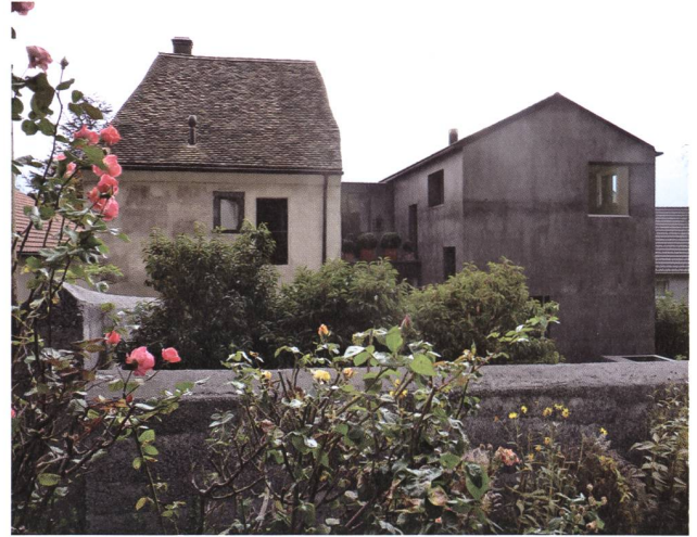
Fläsch GR, Casascura: Altes Weinbauernhaus mit Ergänzungsbau 2007 von Kurt Hauenstein. Foto Kant. Denkmalpflege.
