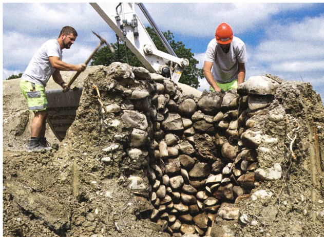
Uzwil, Niederuzwil, Sonnmatt. Polier Roger Brunner (rechts) und Andi Frick beim Abbau des Brunnenschachts. Aufnahme KASG.
