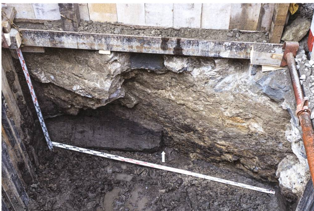
St. Gallen, Unterer Graben. Spätmittelalterliche Kontermauer und Reparatur aus dem 17. Jahrhundert. Aufnahme KASG.
