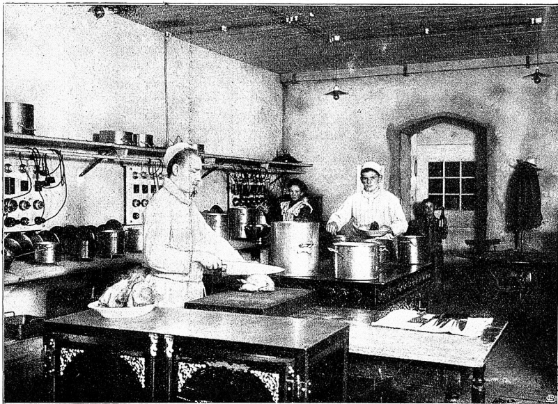
Elektrische Küche auf Station „Eismeer“ der Jungfraubahn. Phot. Krenn.
