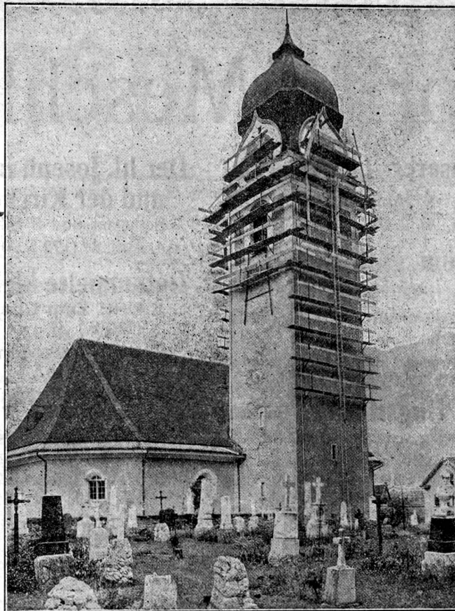
Turm-Gerüst, System „Blitz“ (für Uhr und Verputz-Reparaturen)
