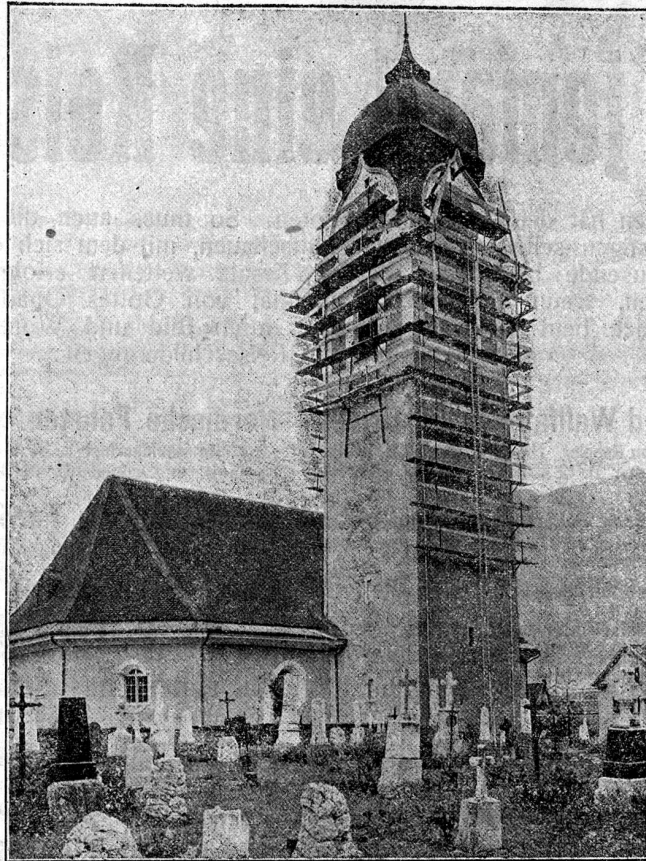
Turm-Gerüst, System „Blitz“ (für Uhr und Verputz-Reparaturen)
