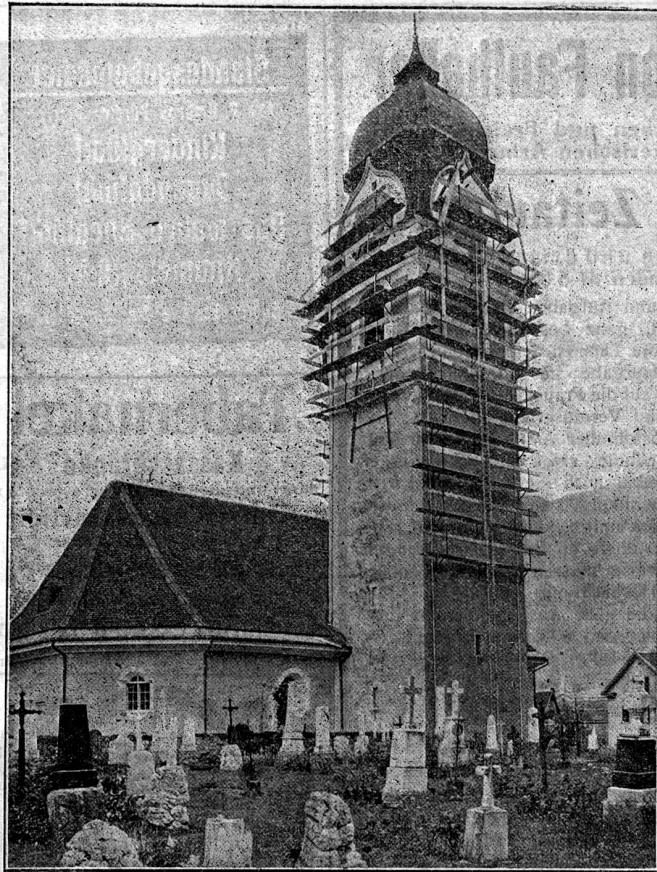
Turm-Gerüst, System „Blitz“ (für Uhr und Verputz-Reparaturen)
