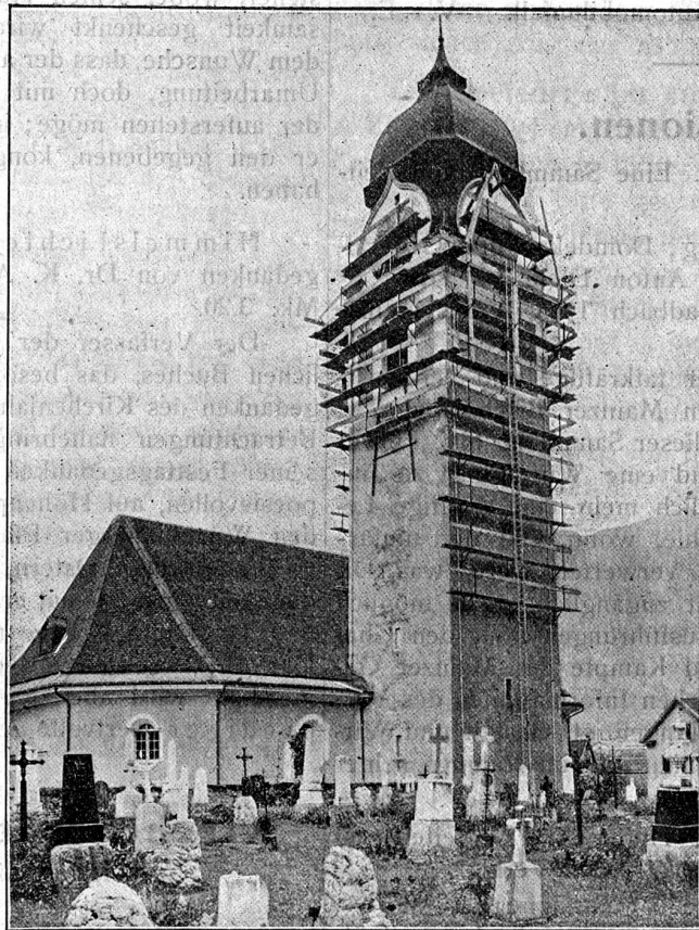
Turm-Gerüst, System „Blitz“ (für Uhr und Verputz - Reparaturen) Za. 2458 g
