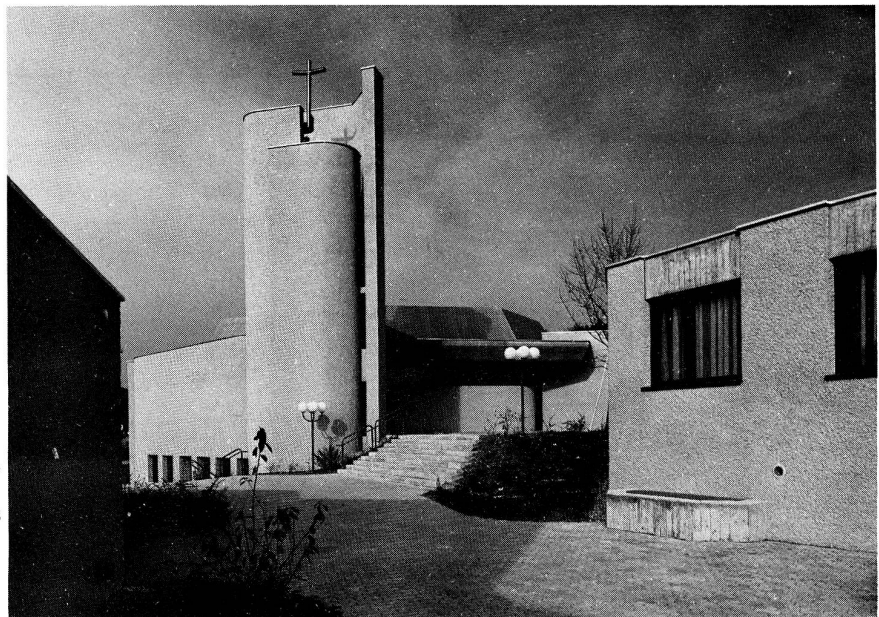
Blick vom Schulweg über die Treppe zum Kirchenaufgang mit Turm.
