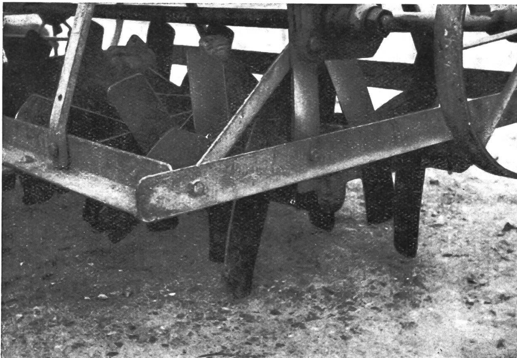
Abb. 12a: Spatenegge mit nachgeschmiedeten, genügend langen Spaten.
