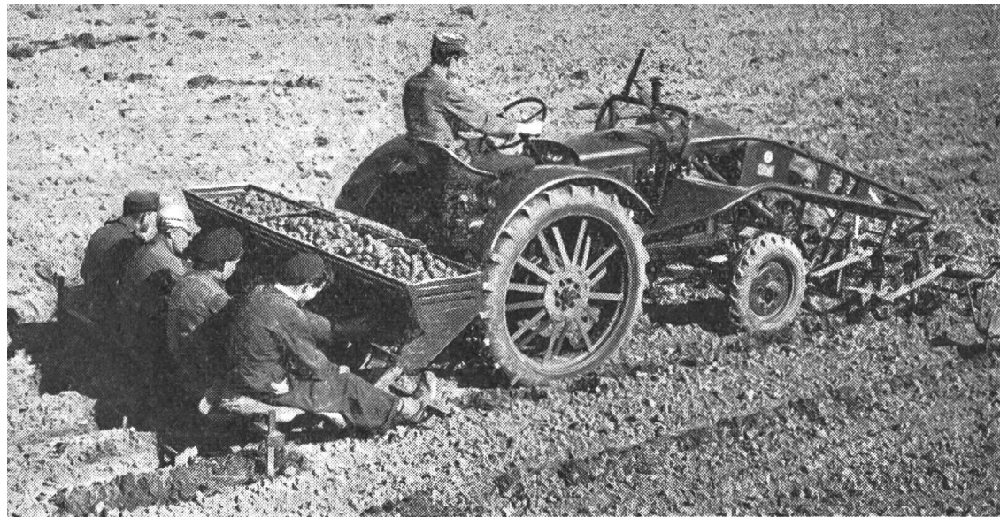
Die Frontlader-Schwinge trägt den Pflanzlochapparat, die Hydraulik die Kartoffellegekiste und vier Bedienungs- personen.
