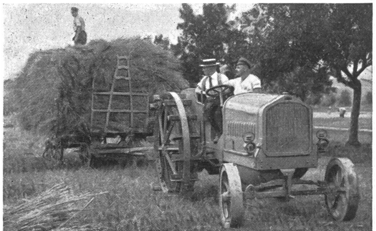
35 Um das Aufreissen der Grasnarbe und der Strassen durch die Stollen zu verhindern, wurde — wo möglich — mit dem sog. Transport-Ring gefahren.
