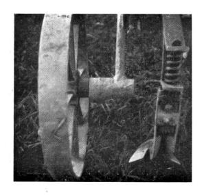
Mit Schutzblech abgedeckte Radnabe eines Kultivators.
