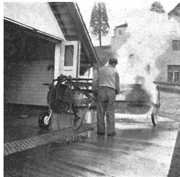
Abb. 4: Freiwaschplatte mit Schlammrost vor dem Waschraum. Traktor in «Arbeit».
