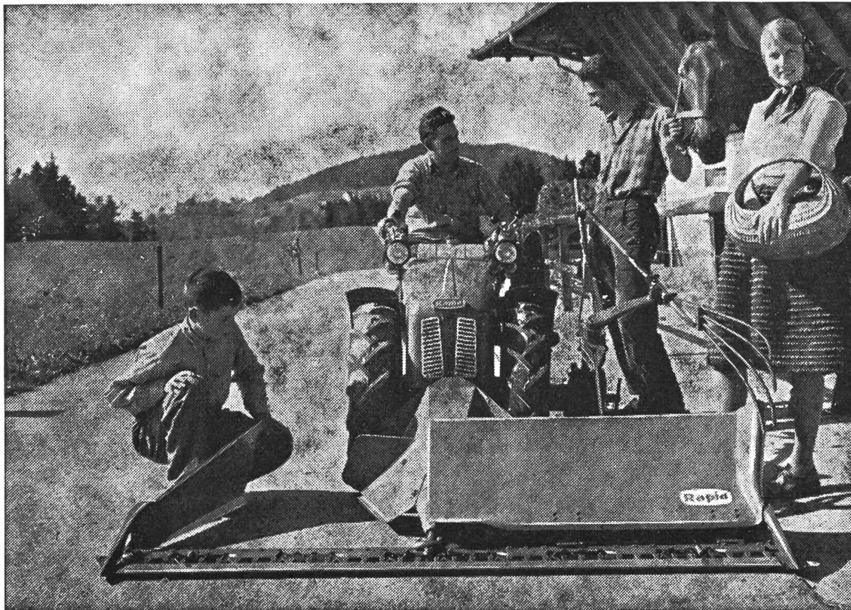
Der neue Rapid 606 ist ein Motormäher mit Differential, ideal zum Eingrasen, Mähen am Hang und in der Ebene sowie zum Ziehen.
